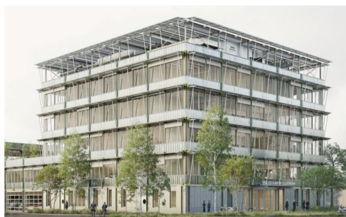
Der Kanton Solothurn will in Oensingen einen neuen Stützpunkt für die Kantonspolizei für 84,5 Millionen Franken bauen. Bild: zvg
